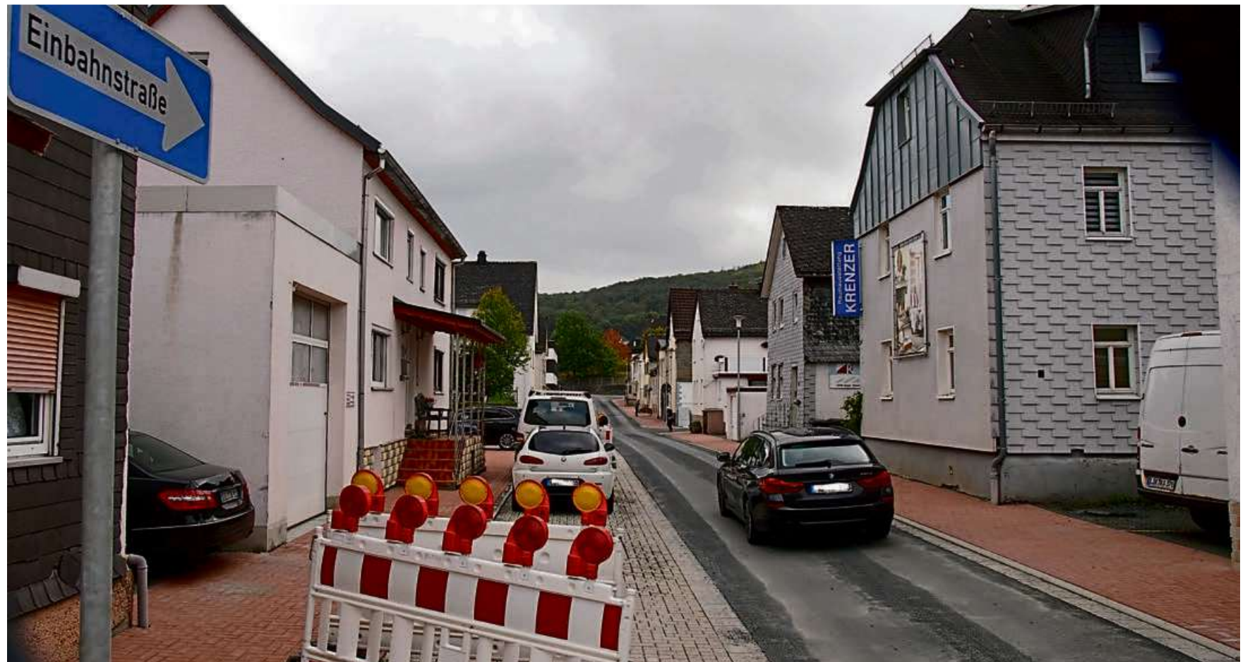
Die Untere Pfarrstraße ist nach drei Monaten wieder für den Verkehr freigegeben worden.
