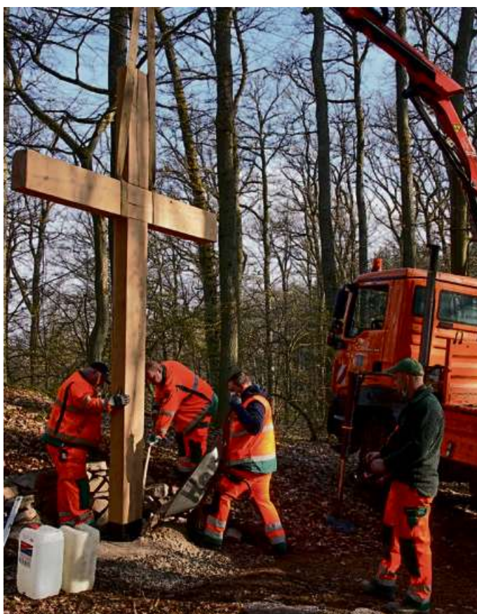
Rund fünf Meter hoch ist das aus Eiche gefertigte Kreuz, das am Dienstag vom Haigerer Bauhof aufgestellt wurde.
