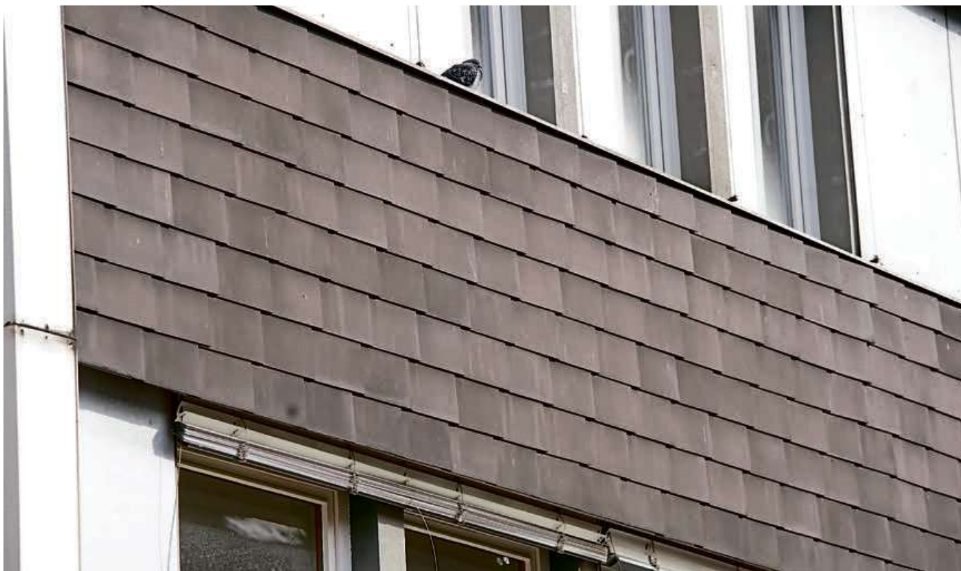
Das Fassadensanierungsprogramm läuft auf Hochtouren. Öffentlich sichtbare Fassaden - wie hier in der Haigerer Kernstadt - können gefördert werden. Foto: Ralf Triesch/Stadt Haiger
