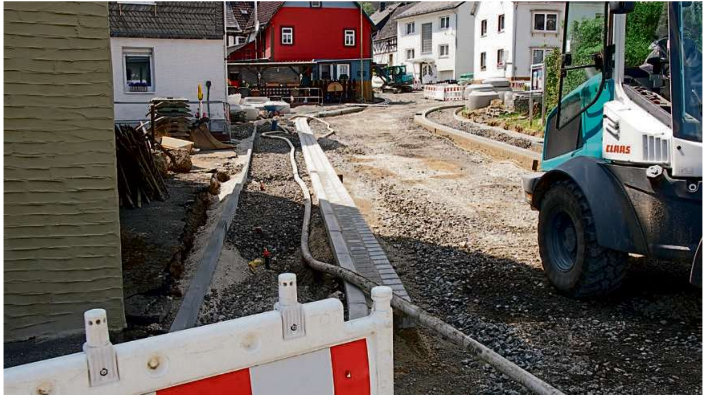
Die Arbeiten in Steinbach laufen. Bald wird asphaltiert.
