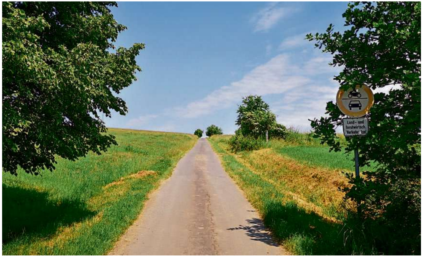
Dieser Feldweg am Kratzenberg wird im Vorfeld des Hessentages asphaltiert. Über diesen Weg werden die Parkplätze erschlossen. Foto: Ralf Triesch/Stadt Haiger
