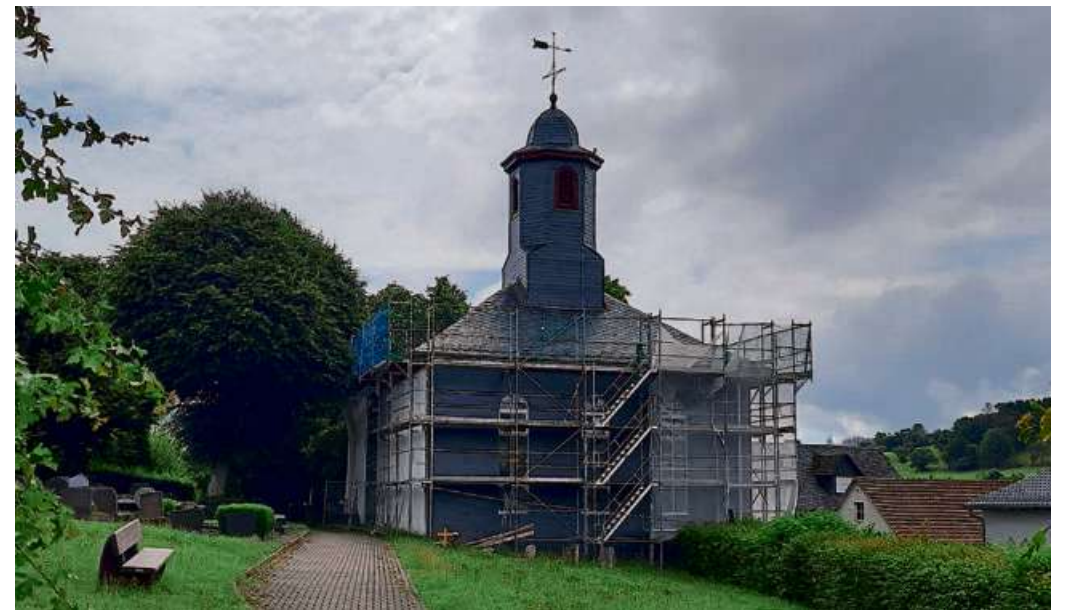
Die Kirche Weidelbach ist noch eine Baustelle. Das Gerüst außen steht noch. Deutlich erkennbar ist das neu gedeckte Schieferdach und die Wandverkleidung. Die Kirche soll im Herbst der Gemeinde wieder übergeben werden. Fotos: Holger J. Becker-von Wolff
