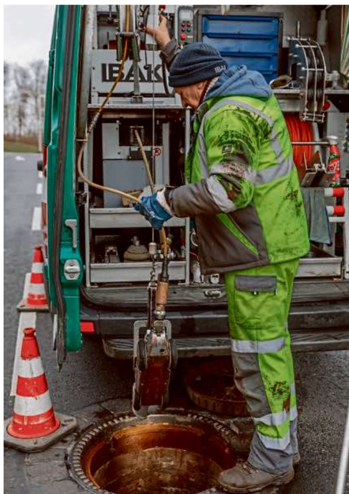
Gleich verschwindet die Kamera im städtischen Kanalnetz. Die Überprüfung des Kanalsystems läuft. Foto: Firma Kuchem
