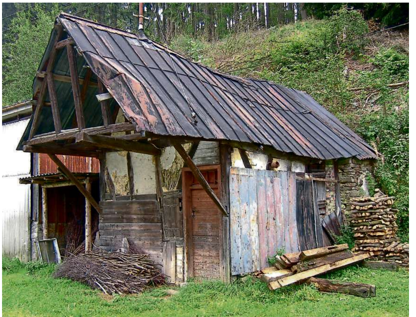
Die alte Schmiede in Offdilln soll restauriert werden. Der Magistrat der Stadt Haiger hat die Arbeiten im Wert von knapp 70.000 Euro vergeben. Foto: Harro Schäfer
