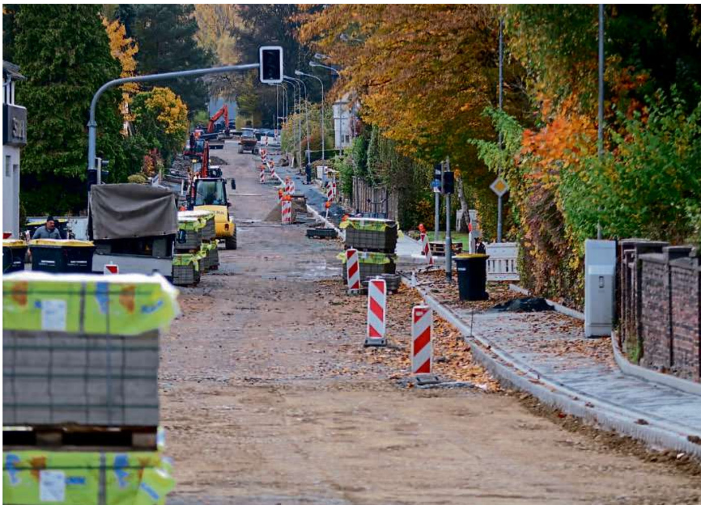
Im November soll der erste Bauabschnitt der Westerwaldstraße asphaltiert werden. Dazu wird dann auch die Zufahrt zur Mühlenstraße über den „Theiße Berg“ gesperrt. Foto: Ralf Triesch/Stadt Haiger
