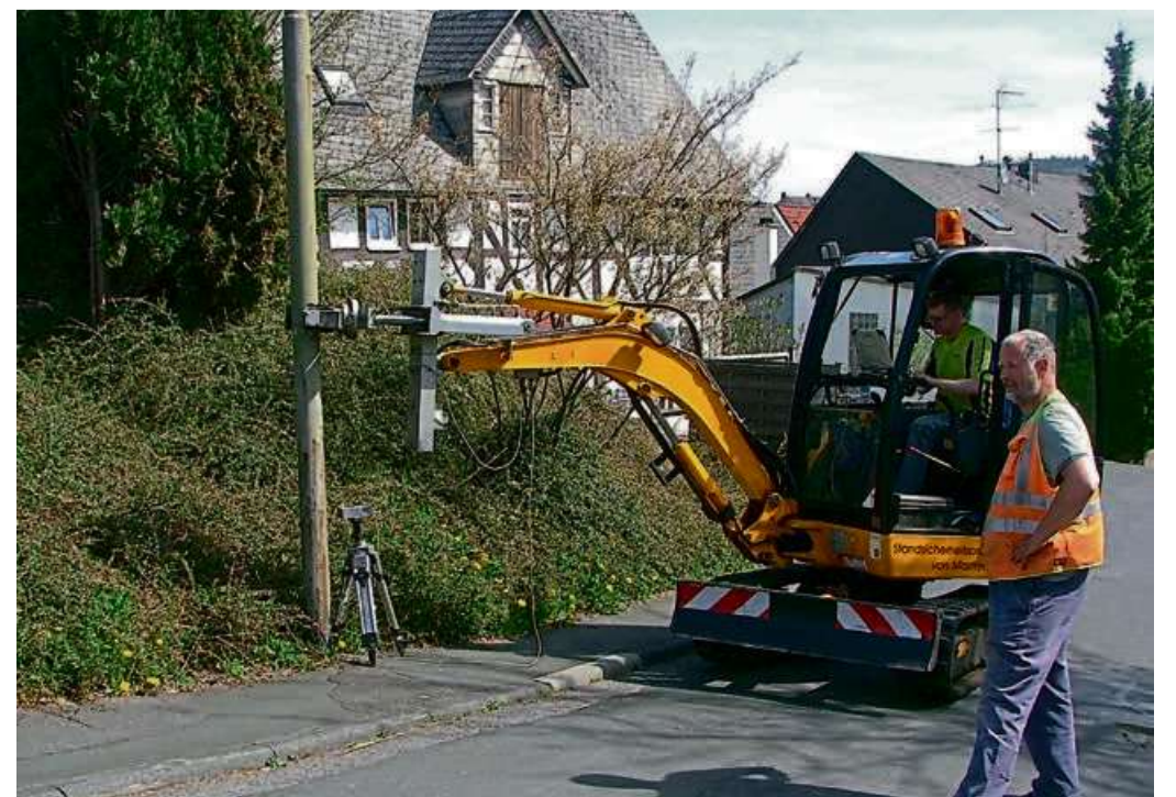
Ein Einsatzfahrzeug (Minibagger) mit hochentwickelten Prüfgeräten am Straßenbeleuchtungsmast. Foto: Ohlenburger/Stadtwerke Haiger
