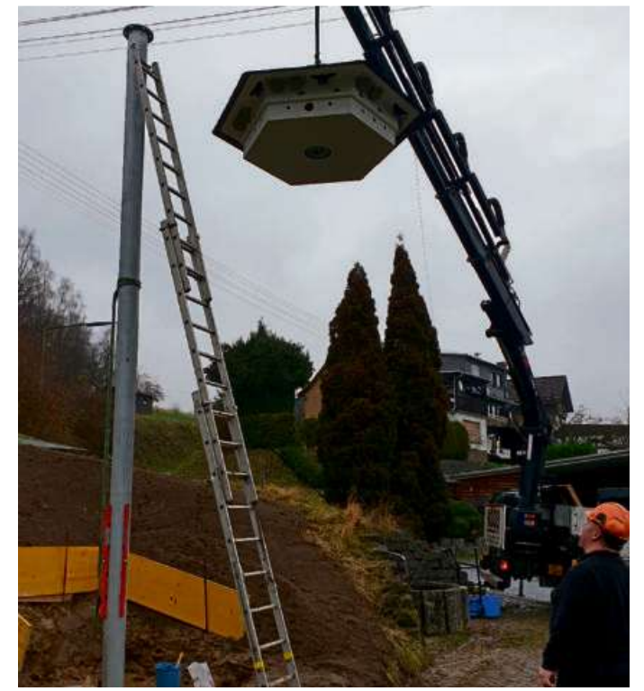
Mit einem Kran wurde das Schwalbenhaus an seinen neuen Standort transportiert.
