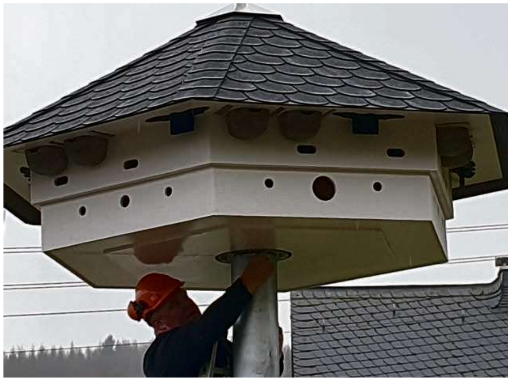
Das Schwalbenhaus konnte durch Unterstützung der Stadt Haiger und der Unteren Naturschutzbehörde installiert werden. Fotos: Vogel- und Naturschutzverein
