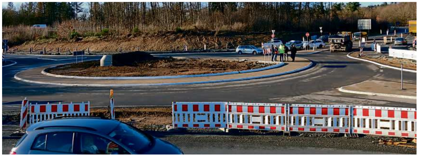
Der Kreisverkehr auf der Kalteiche kann befahren werden.
