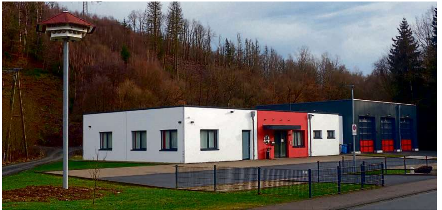
Direkt neben dem Feuerwehrhaus wurde der sieben Meter hohe Turm montiert.
