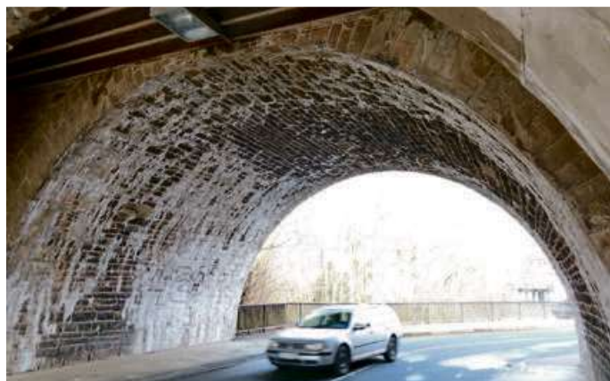
Die Gewölbebrücke ist zum Teil gemauert, zum Teil besteht sie aus Beton.
