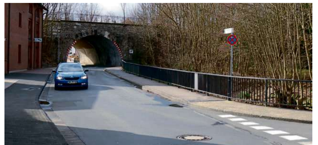
An der Kreuzung Aubachstraße/Burgstraße endet ab Samstag die Durchfahrtsmöglichkeit in Richtung Friedhofsweg und „Kälberwiese“.
