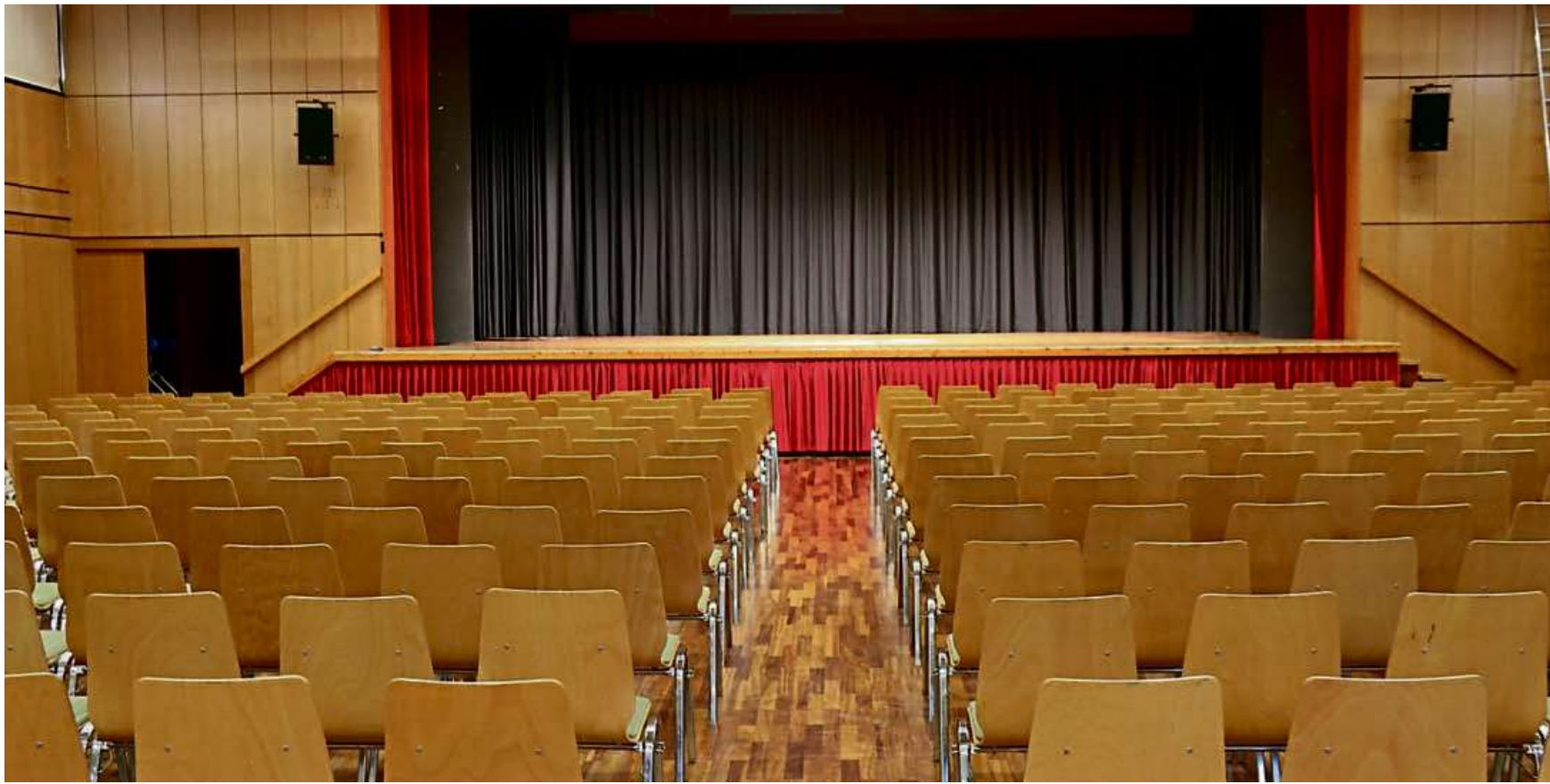
Viele hundert Veranstaltungen fanden in der Haigerer Stadthalle statt. Jetzt wird sie den aktuellen Anforderungen angepasst. 2024 soll die Sanierung abgeschlossen werden. Foto: Ralf Triesch/Stadt Haiger
