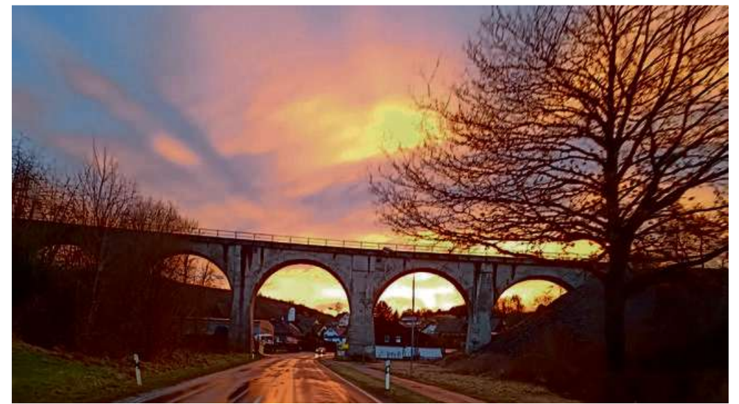
Flammersbach mit Bahnviadukt.
