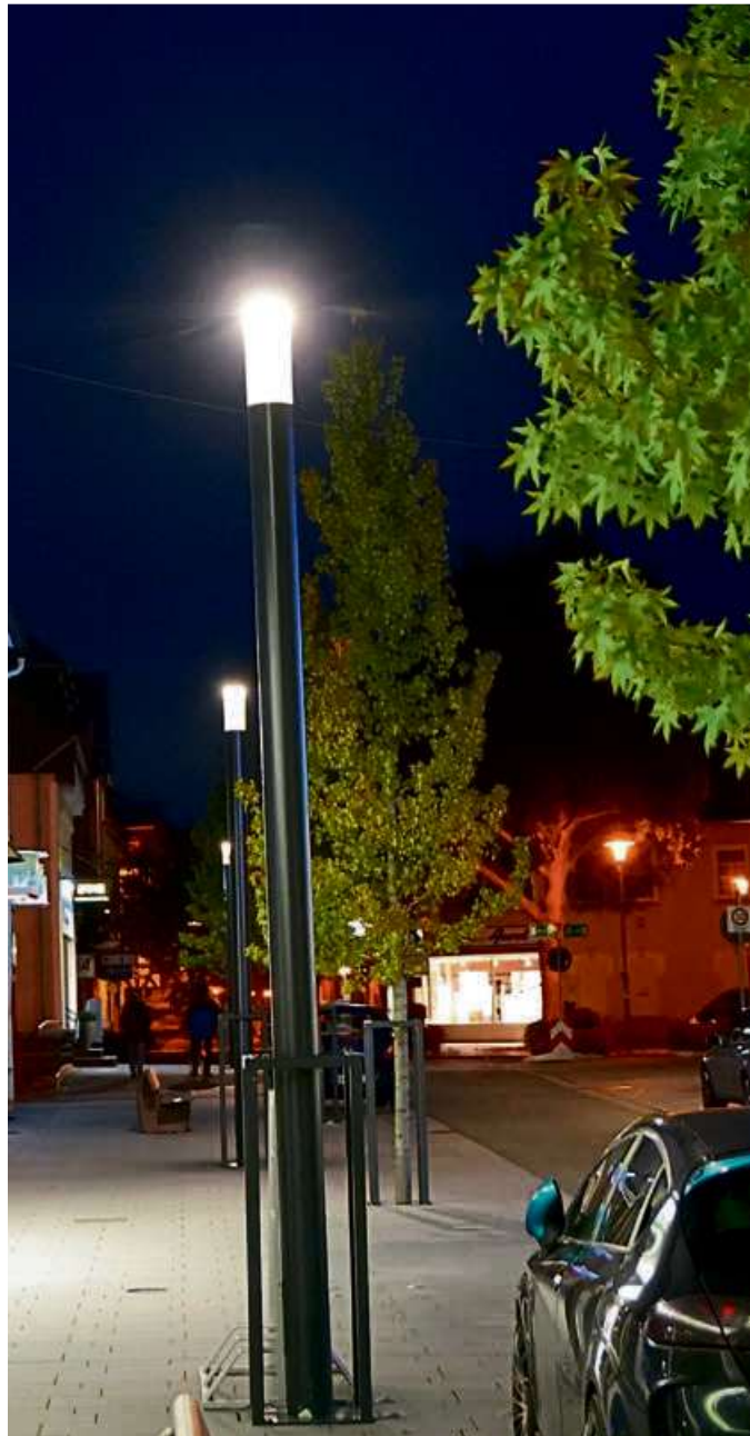
Wenn eine Straßenlampe defekt ist, lässt sich eine Information mit wenigen Klicks an die Stadtverwaltung schicken.
