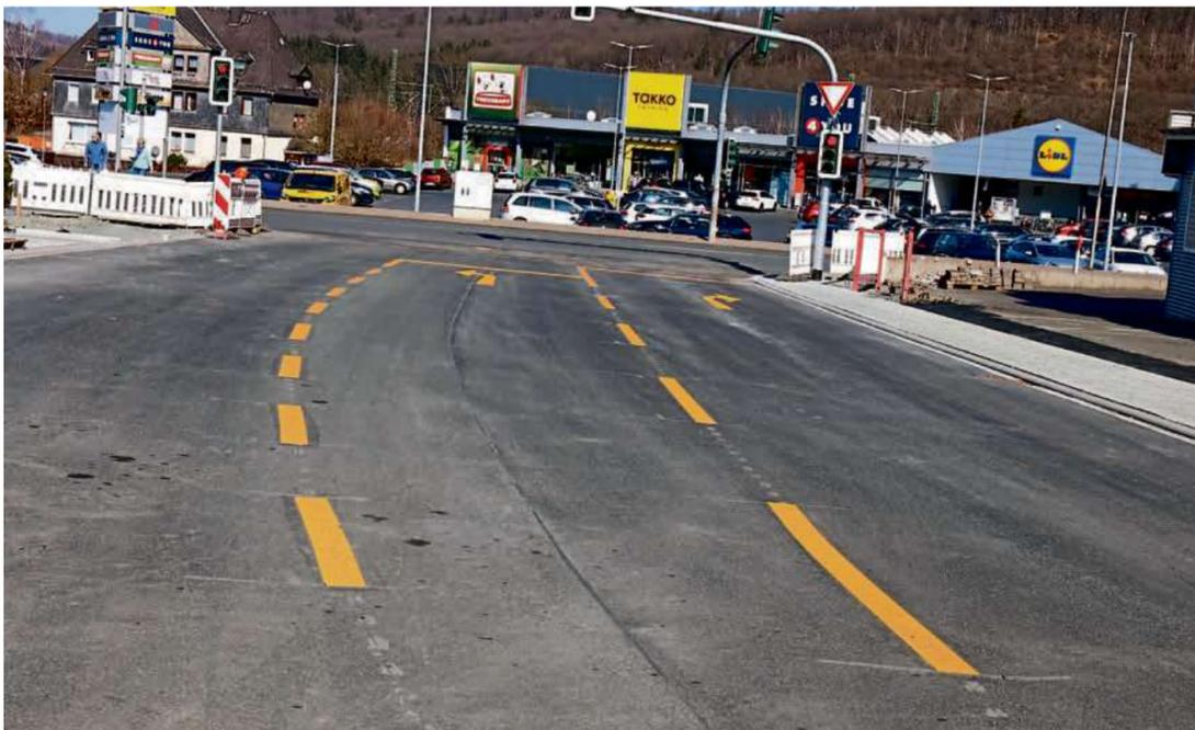
**Aufgrund der Kälte sind die Fahrbahnmarkierungen noch in gelber Farbe „aufgemalt“. Das ändert sich aber, sowie die Temperaturen konstant höher liegen.**
