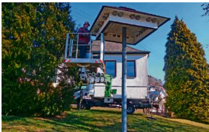
Die Arbeitsbühne wurde von Dieter Vogt gesteuert und in Position gebracht. Foto: Harro Schäfer
