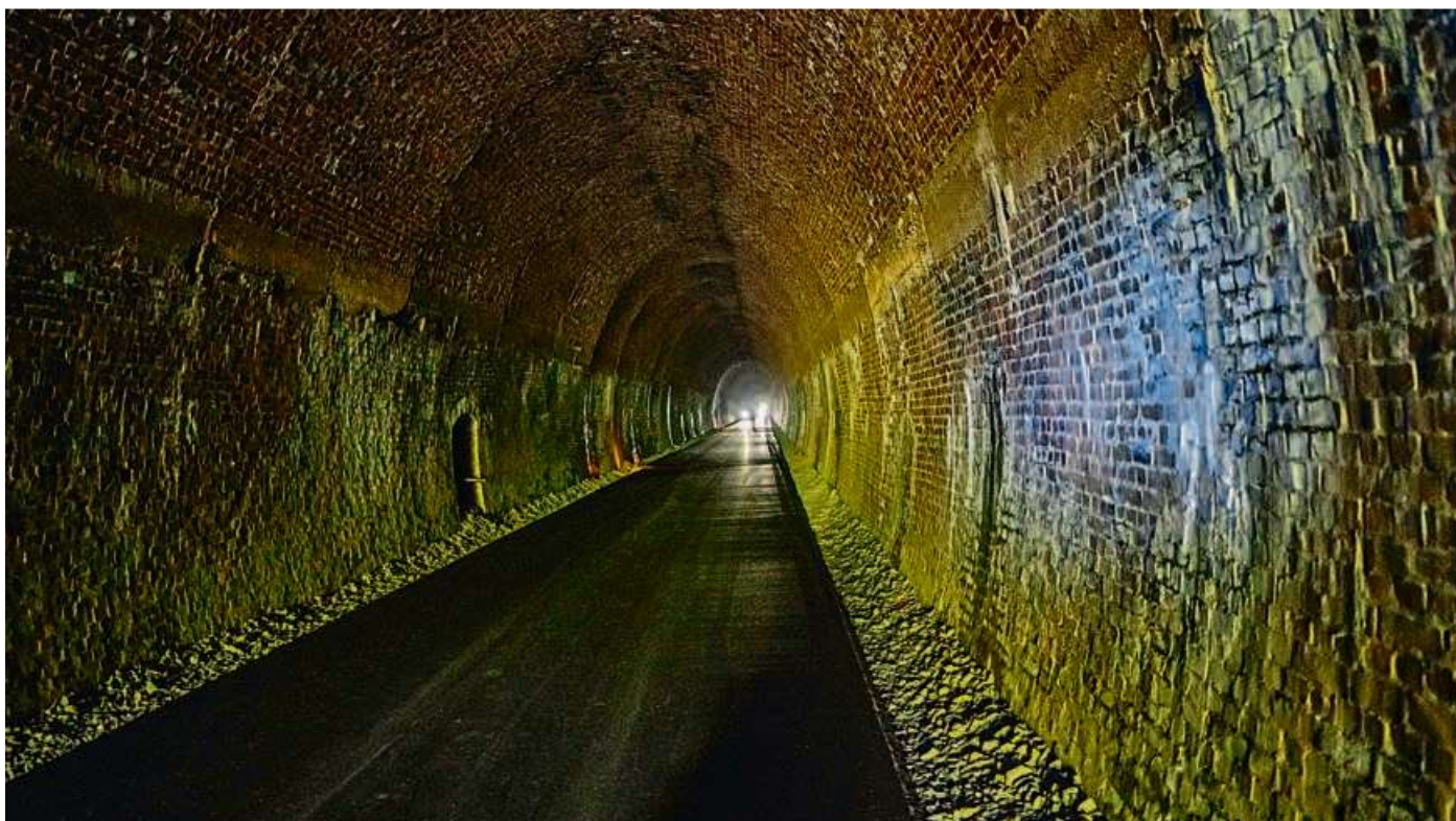
Die Asphaltierungsarbeiten im Tunnel sind zum großen Teil abgeschlossen.
