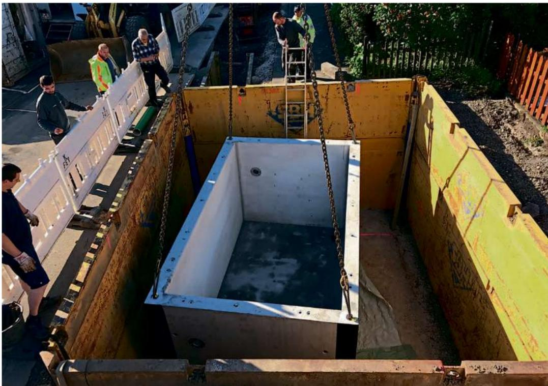
Mit einem leistungsfähigen Autokran wird das rund 30 Tonnen schwere Betonbauwerk in die Baugrube in Langenaubach abgelassen. Foto: Ute Thielmann/Stadtwerke Haiger
