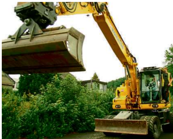
Auf dem großen Außengelände durften die jungen Messebesucher auch mal eine kleine Testfahrt mit einem Bagger unternehmen. Foto: Lea Siebelist/Stadt Haiger
