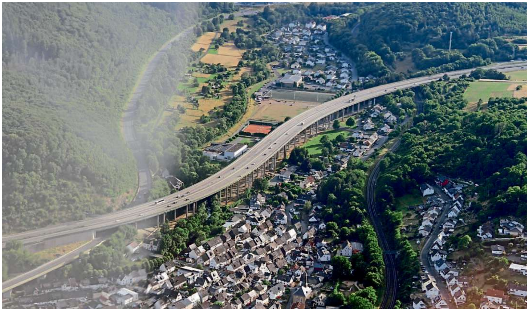
Die Sechsheldener Talbrücke ist 940 Meter lang und liegt zwischen den Autobahnanschlüssen Haiger-Burbach und Dillenburg. Sie überspannt östlich von Haiger in einer Höhe von maximal 25 m mit 19 Feldern das Tal der Dill sowie die Bahnstrecke von Haiger nach Dillenburg, die Bundesstraße 277 von Haiger nach Dillenburg und Gemeindestraßen von Sechshelden.
