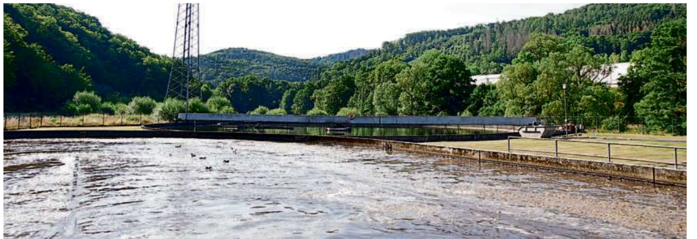
In den nächsten Jahren soll die Haigerer Kläranlage zur Eigenstromerzeugung aus- und umgebaut werden. Dafür ist eine Erweiterung der Fläche notwendig. Das Nachbargelände talwärts, für das auch der Retentionsraumausgleich vorgesehen ist, wurde bereits als Erweiterungsfläche angedacht. Foto: Lea Siebelist/Stadt Haiger
