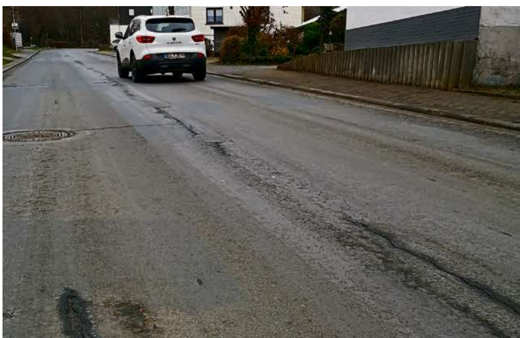
Die Ortsdurchfahrt in Weidelbach wird ausgebaut.
