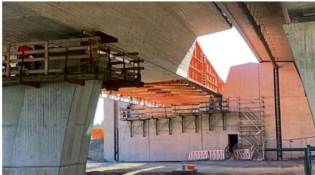
Im Schneckentempo bewegte sich die Talbrücke Kalteiche Richtung Widerlager. Neun Meter legte sie in der Stunde zurück. Foto: Autobahn Westfalen/Anke Bruch
