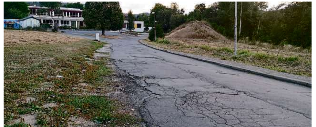
Die Straße am Vogelsgesang wird zwischen Gasstation und Budenberg-Schule komplett erneuert. Foto: Ralf Triesch/Stadt Haiger
