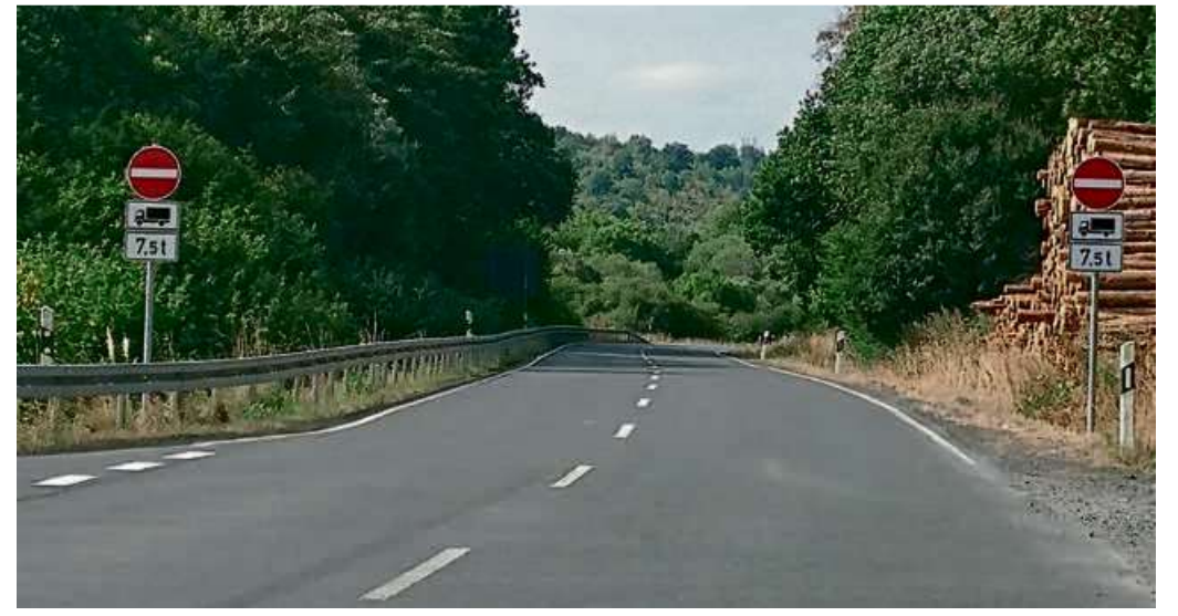
Zwei Sperrschilder wurden auf der L 3044 montiert.
