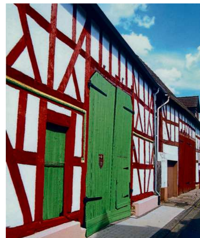
Blick ins Scheunenviertel der oberen Dillstraße. Erfreulich die frische Farbgestaltung der Scheune. Foto: Erich Cuntz
