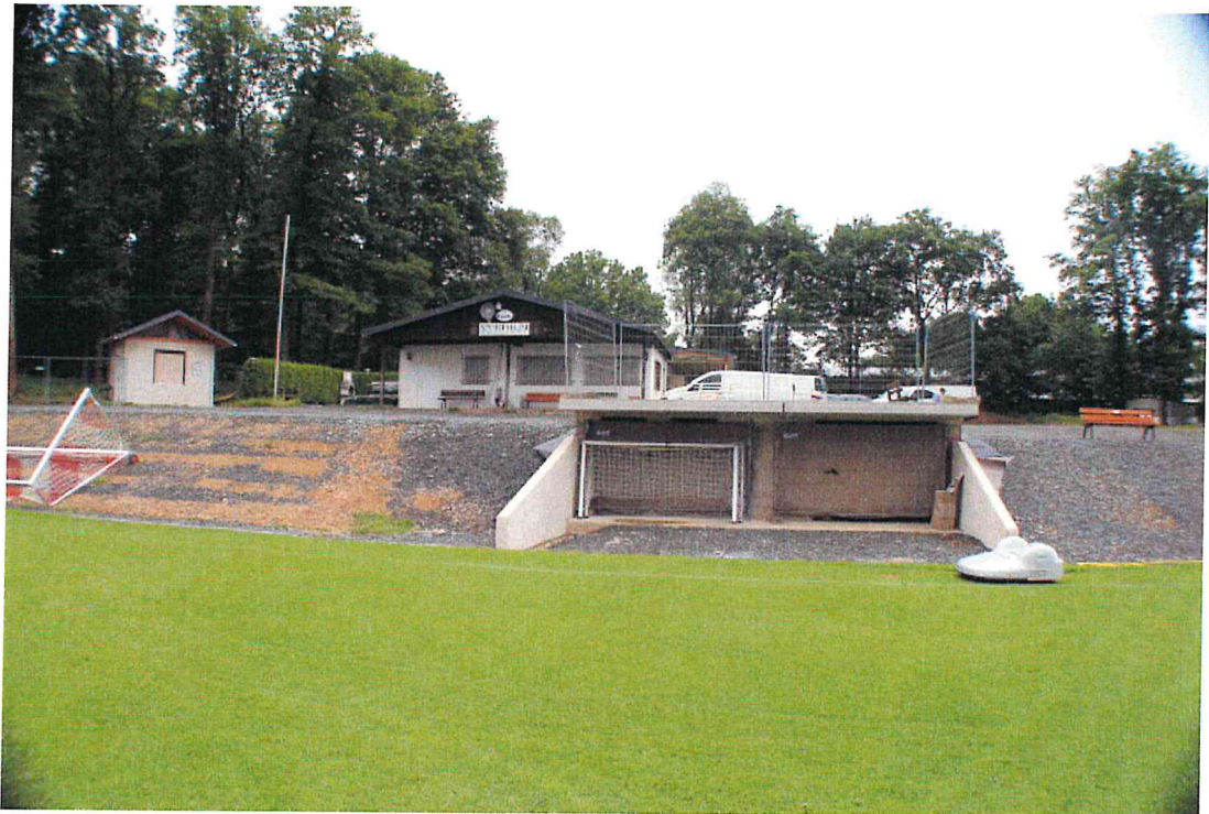
Abb. 2: Böschung und Abstell-/Geräteraum
