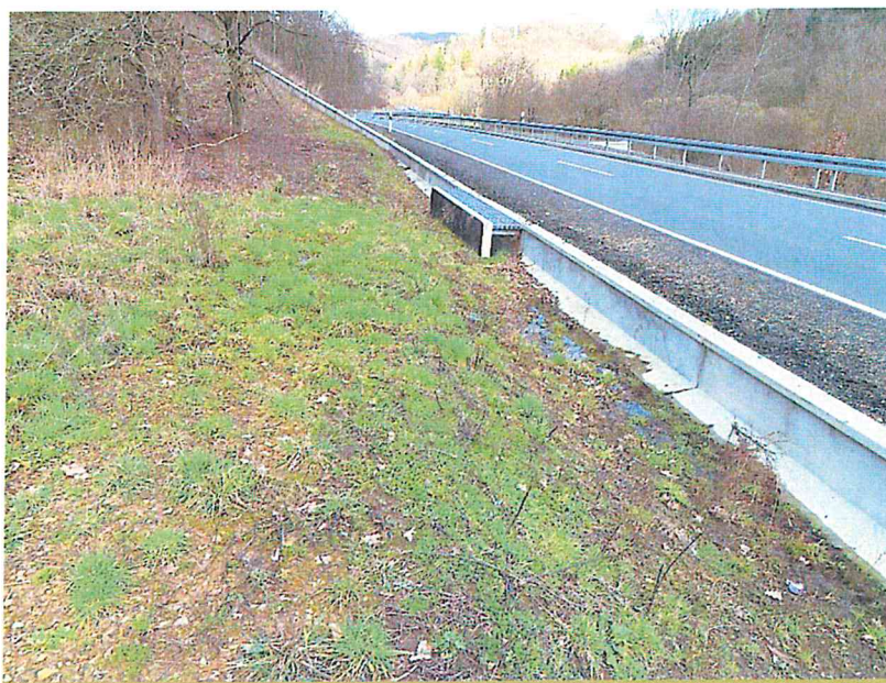
Abbildung 5: Beispiel eines dauerhaften Amphibien-/Reptilienschutzzaunes mit suboptimal gestalteter Lauffläche
