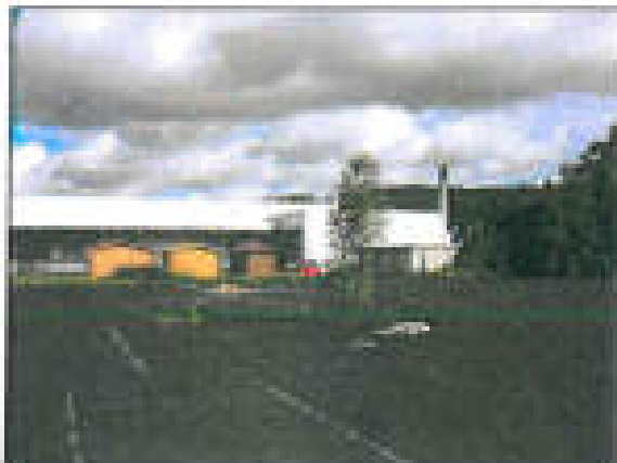
Abb. 4: Parkplatz im östlichen Bereich
